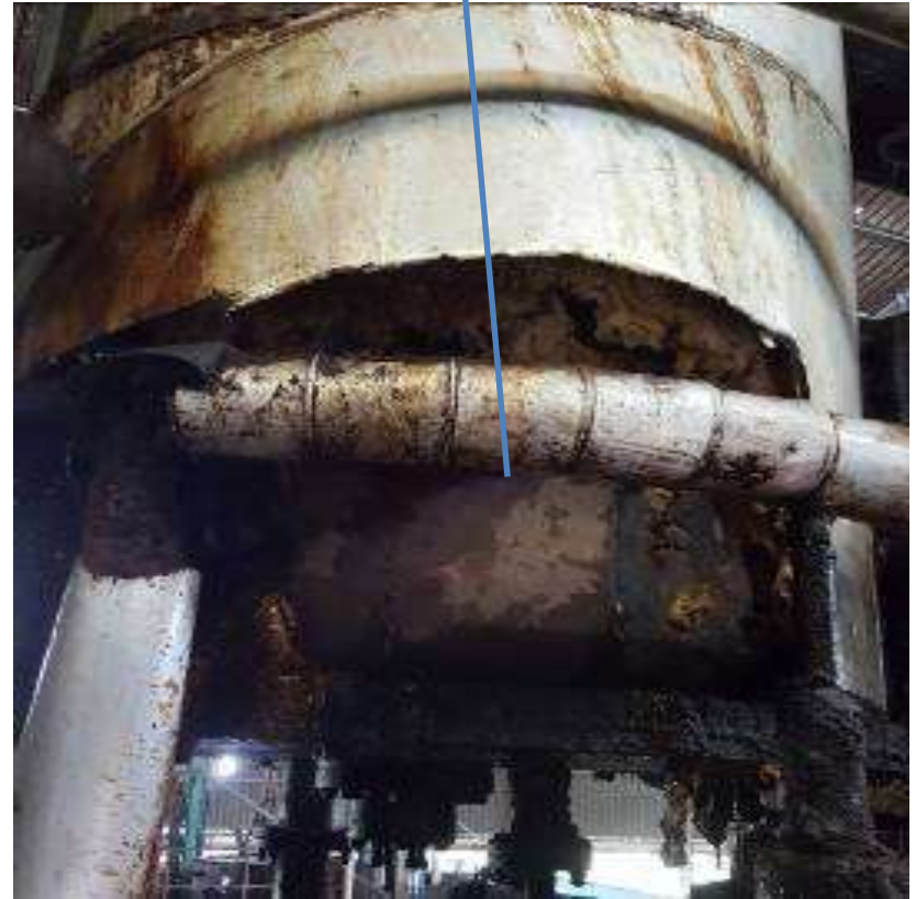
Lapisan Jacket isolasi sudah lepas
